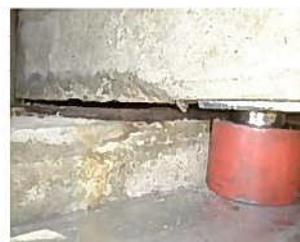
油圧ジャッキによる橋梁持ち上げ状況
