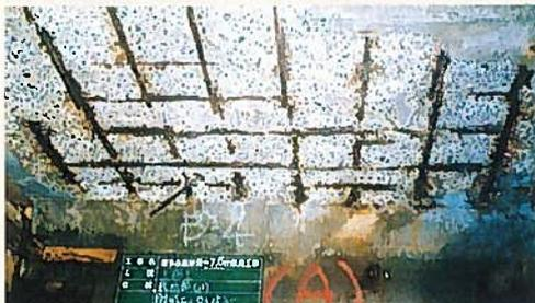
■ 床版破傷状況(剥離・鉄筋露出)ランクA
