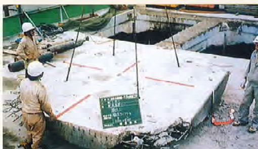
■ 床版撤去(クレーン)
