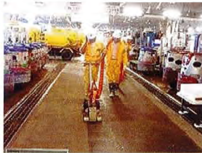
施工完了の様子。コンクリート表面に凹凸ができ、転倒防止につながった
