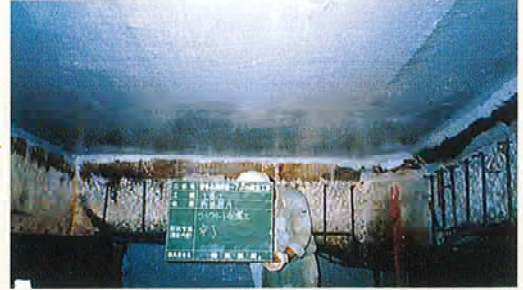
■ コンクリート保護工(ガラスクロスライニング)
