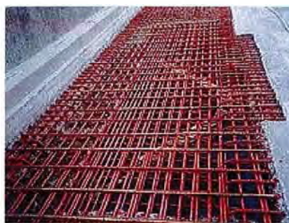
床版 貫通はつり
