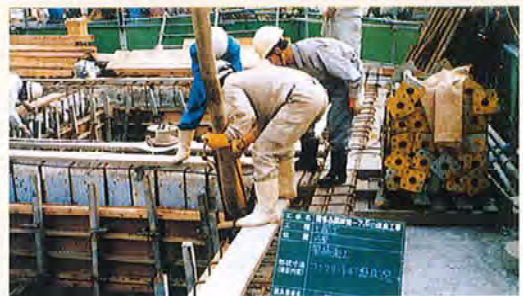
■ 梁部コンクリート打設状況
