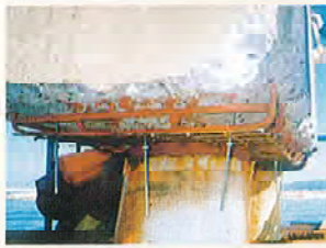
■研り工・鉄筋の防錆
