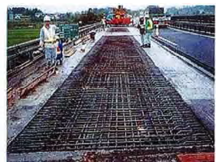
PC床版 貫通はつり
