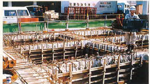
■ 梁部補強(鉄筋・型枠組立)
