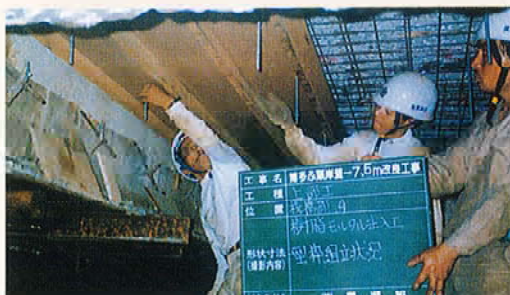
■ 樹脂モルタル注入(研り・型枠組立)
